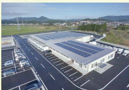
2012年より、事業所への太陽光発電設備の設置をすすめています。写真はコープデリ笠間センターです。
